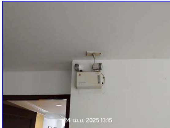
รูปที่ 2.32 เครื่องสำรองไฟฉุกเฉิน
