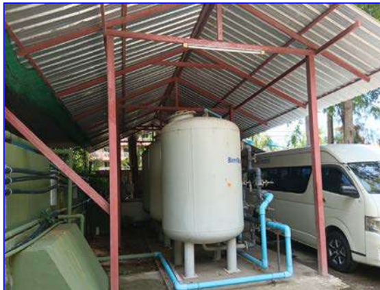
รูปที่ 2.3 ระบบกรองน้ำใช้หลักของโครงการ
