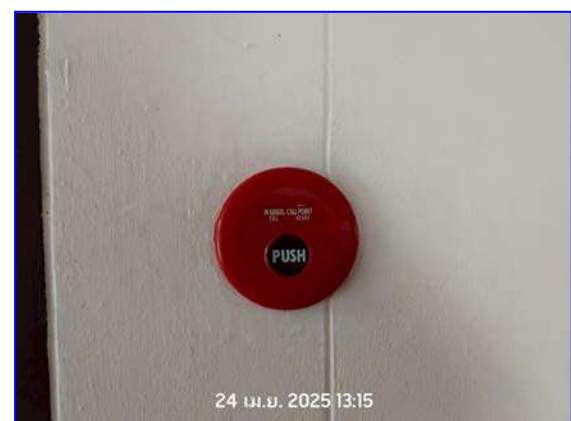
รูปที่ 2.31 สัญญาณแจ้งเหตุเพลิงไหม้
