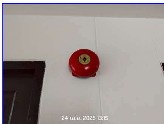
รูปที่ 2.31 สัญญาณแจ้งเหตุเพลิงไหม้
